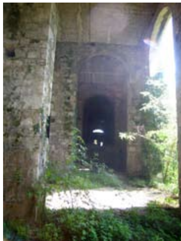
Spazio Italcementi prima dei lavori di riqualificazione
