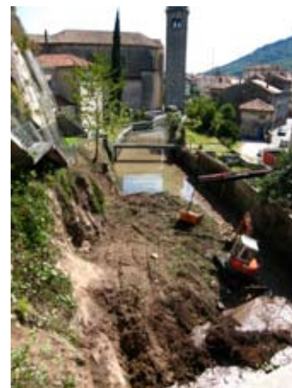
Spazio Italcementi durante i lavori di riqualificazione
