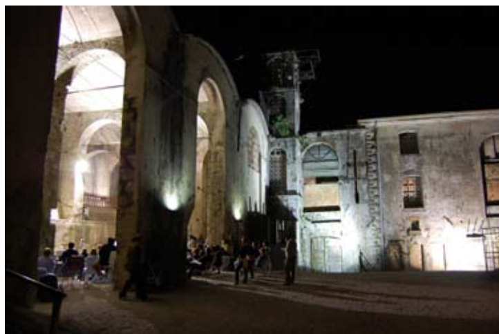
Spazio Italcementi dopo i lavori di riqualificazione
