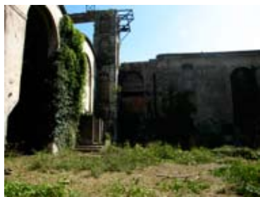
Spazio Italcementi prima dei lavori di riqualificazione
